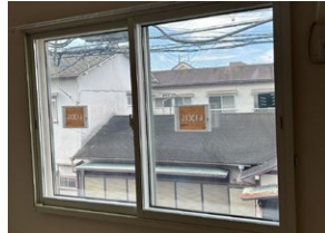
主居室の南側に内窓設置
